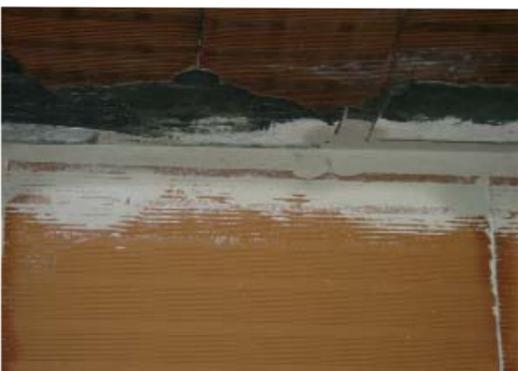
10. El encuentro con el forjado superior se realiza dejando una junta de 3 a 4 cm que se rellena con yeso de fraguado controlado.
