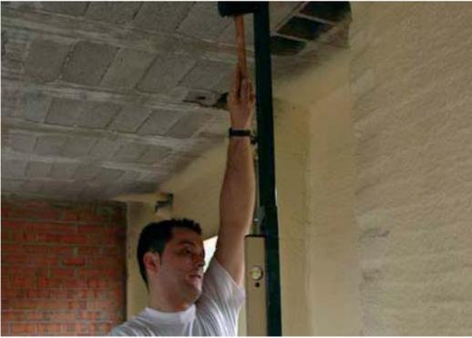
1. Para empezar, se colocan las reglas siguiendo el trazado que marca el replanteo sobre el forjado.
